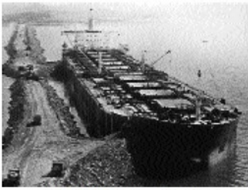
Năm 1984. Hoàn tất con đập với sự trợ giúp của chiếc tàu chở dầu.
