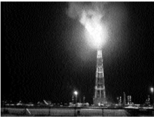
Cơ sở phân phối khí đốt do Hyundai xây dựng.
