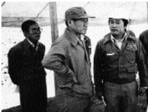
Thập niên 1970. Kiểm tra tiến độ tại công trường xây dựng thuộc dự án xây dựng nhà ở cho người dân ở thành phố Jeda, Ả-rập Sau-đi.
